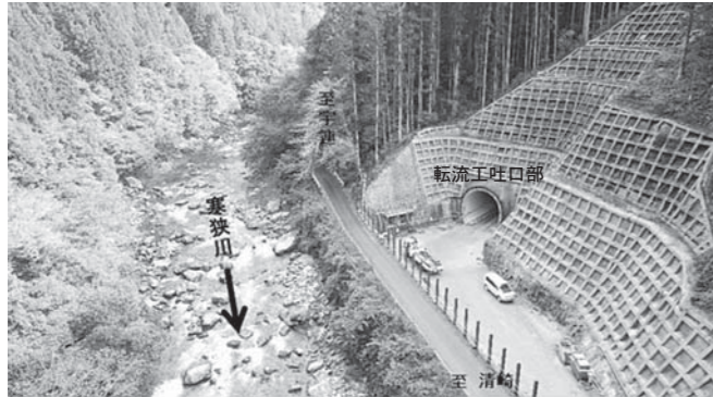
① H28設楽ダム転流工工事
