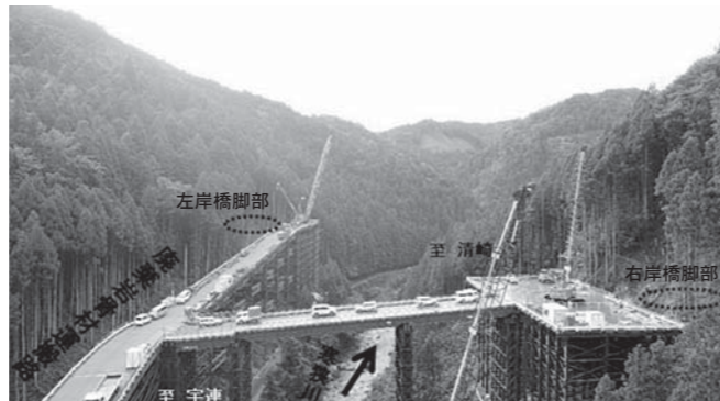
⑨ H29設楽ダム瀬戸設楽線5号橋右岸下部工事
