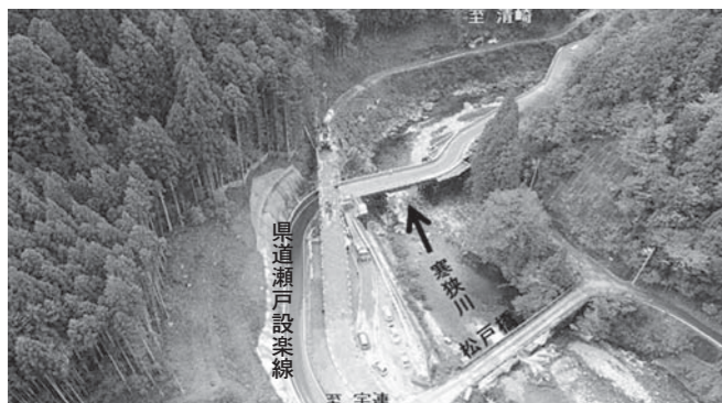
⑫ H31設楽ダム工事用道路迂回路整備工事
