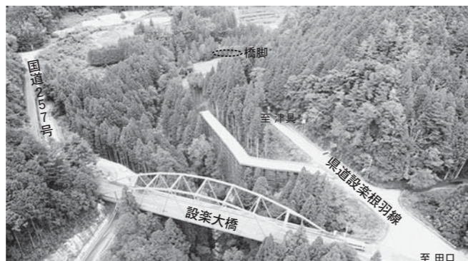
⑬ R1設楽ダム国道257号4号橋進入路工事
