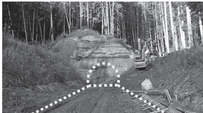
⑧ H31設楽ダム設楽根羽線1号トンネル工事
